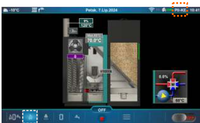
Zaslon kotla (PII-KE)
