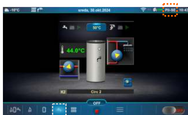
Zaslon tople sanitarne vode (TSV) (PII-SE)
