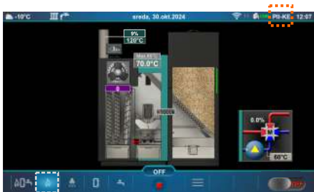
Zaslon kotla (PII-KE)
